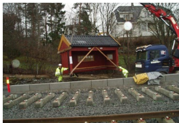
Ved oppgradering av banestrekninger er det også viktig å ivareta historien. Her vist ved at et verneverdig lehus løftes tilbake på plass på Sæter holdeplass, Ekebergbanen, i forbindelse med oppgraderingen av holdeplassen.
