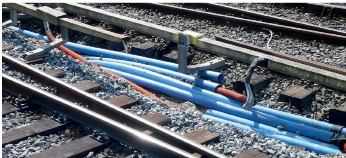
Bilde av Majorstuen stasjonsområde i dag, som har behov for oppgradering.
