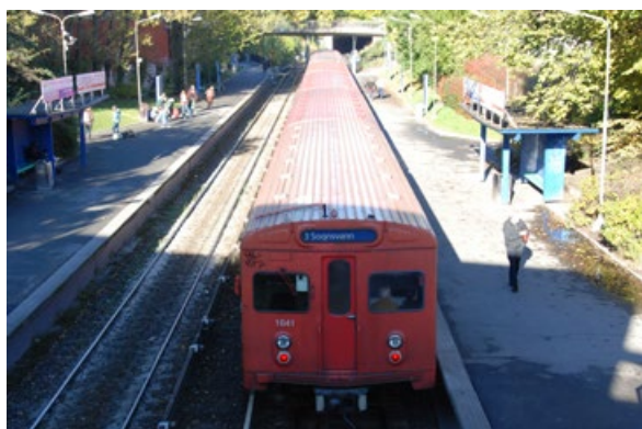
Ensjø stasjon før ombygging
